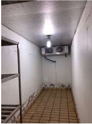
Câmara fria desligada, sem uso
