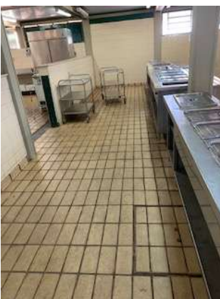
Adequação/Reforma da cozinha
