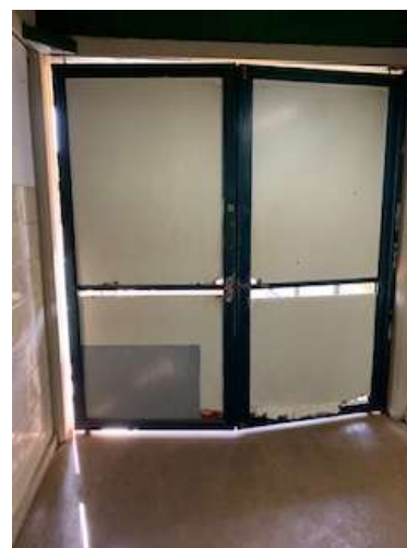
Manutenção/Troca de portas
