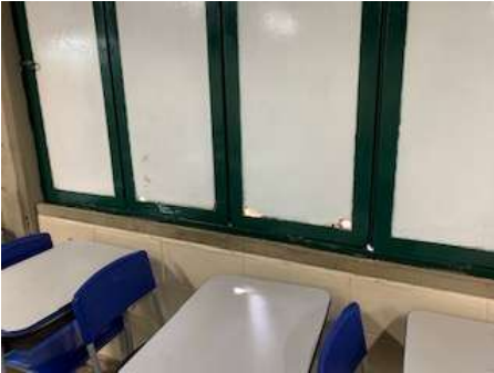
Manutenção/Troca das janelas
